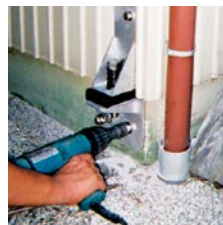
下部金具の取付
