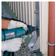
上部金具の取付
